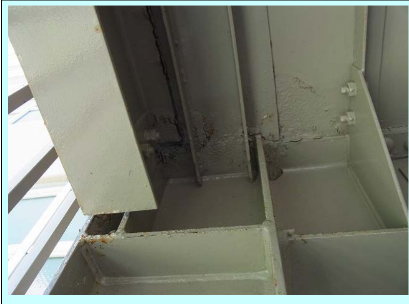
鉄骨階段揚げ裏
