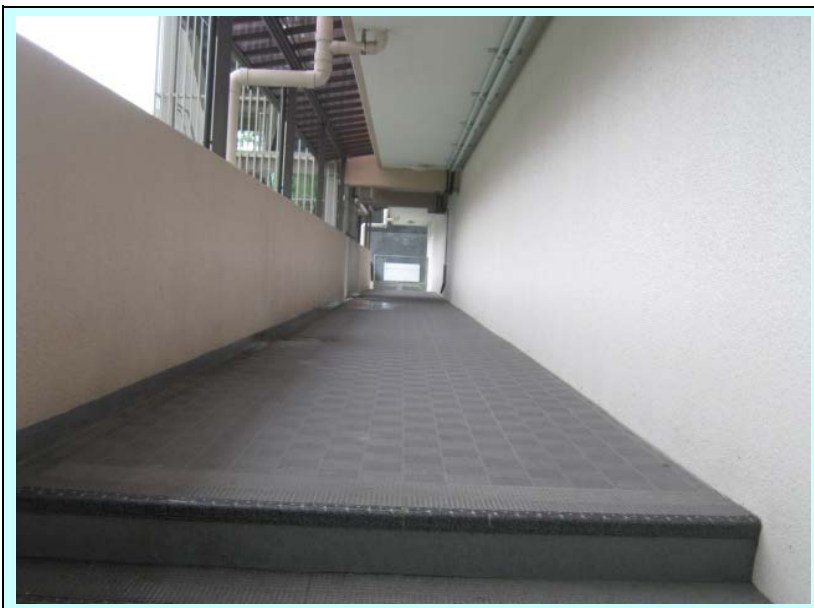
共用廊下壁面 現状
