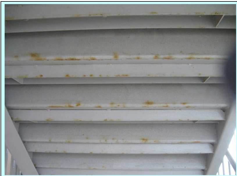
鉄骨階段揚げ裏
