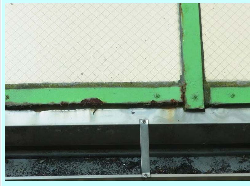
エントランス通路
