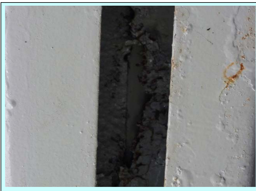
鉄骨階段揚げ裏
