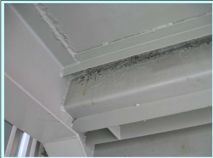
鉄骨階段揚げ裏
