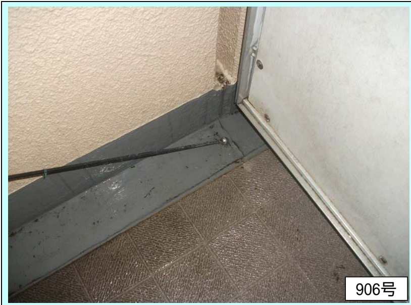
ベランダ内部
