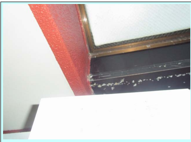
最上階ガラス屋根、鉄骨部
