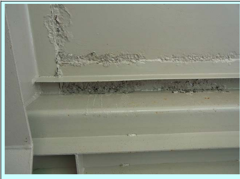
鉄骨階段揚げ裏
