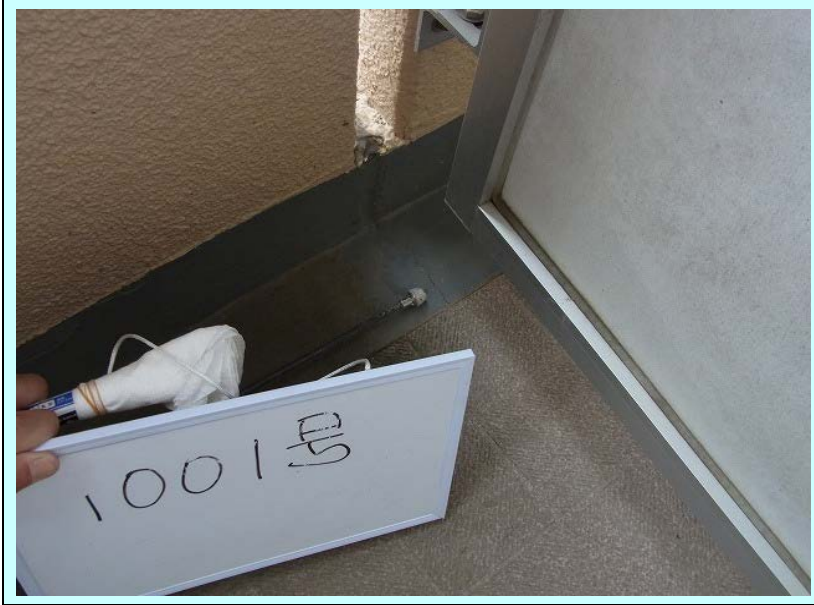
ベランダ内部
